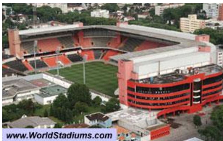
Figura 11 - Estádio Arena da Baixada.
