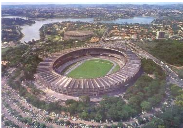
Figura 4 – Vista aérea do Estádio Governador Magalhães Pinto – Mineirão.
