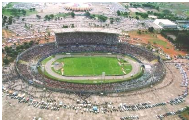
Figura 7 - Estádio Mané Garrincha
