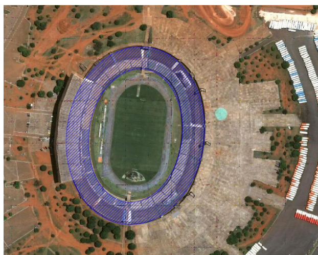
Figura 8 - Estádio Mané Garrincha, com área total para integração fotovoltaica hachurada em azul.
