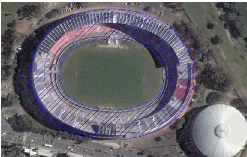
Figura 18 - Área disponível para integração fotovoltaica no estádio Beira Rio.
